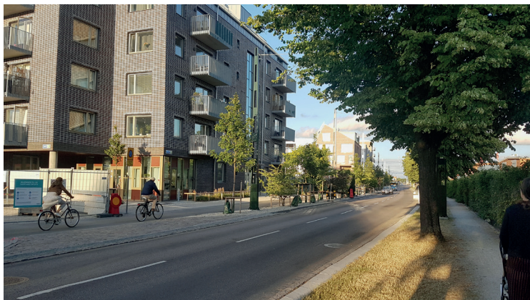
Nybyggnation längs Industrigatans norra sida.
