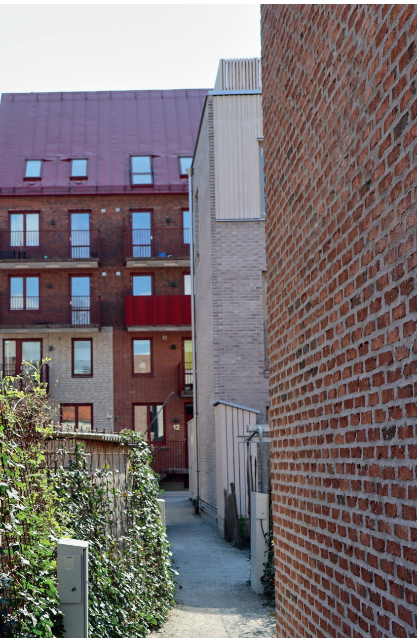
Radhus i kvarteret Spårvägen.
