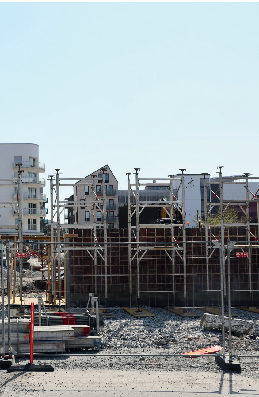
Byggarbetsplats i Norra Sorgenfris nordvästra hörn.
